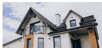
DANS LE SECTEUR DU LOGEMENT
