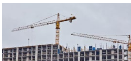
SUR UN CHANTIER DE CONSTRUCTION
