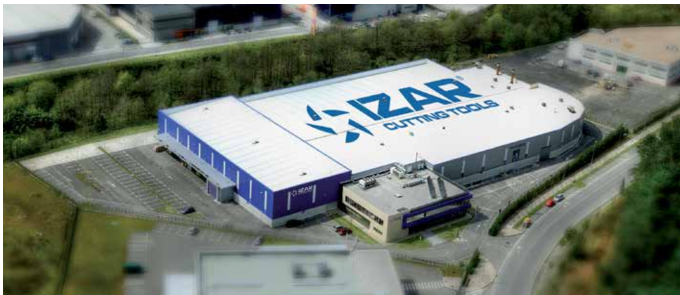
L'usine Izar Cutting Tools d'Amorebieta couvre une superficie de 24 000 m 2 , en incluant la partie logistique. La partie production travaille en 3/8 cinq jours sur sept avec un effectif de 110 personnes.
