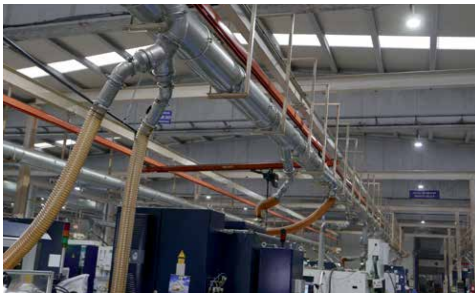
L'usine Izar comporte deux réseaux de recyclage de l'huile de coupe en circuit fermé, un pour la production des outils HSS et l'autre pour celle des outils carbure. Les fluides sont recueillis par des collecteurs qui les conduisent jusqu'aux unités de traitement situées en sous-sol.
